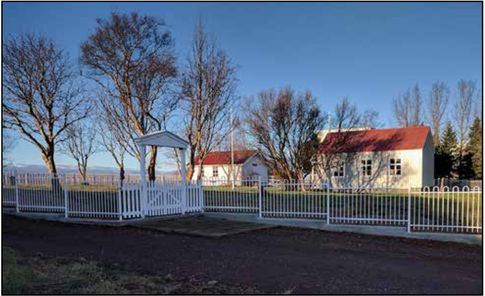
Eiðar eftir framkvæmdir
